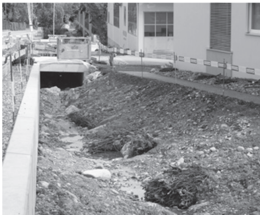
Neues Bachbett für den Glasbach.
