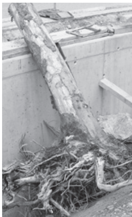
Baumstrunk wird als Lebensraum für Tiere im Bachbett eingebaut.
